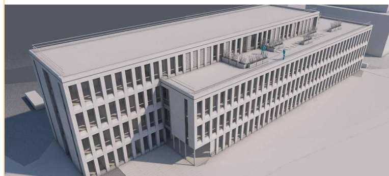
Forschungszentrum Jülich in Stahlrahmenmodulbauweise
