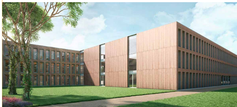
Größte Schule Europas | Gymnasium Frankfurt-Nord Westhausen in Holzmodulbauweise
