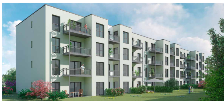
Wohnanlage Leverkusen in Stahlrahmenmodulbauweise
